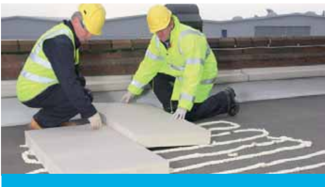
Abb. 16: Verklebung von EPS-Platten auf einer bituminösen Dampfbremse
