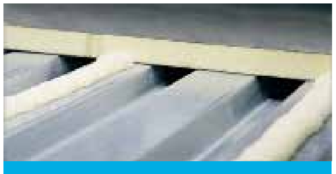
Abb. 06: Verklebung einer kaschierten PU-Dämmplatte auf ein Stahlprofil
