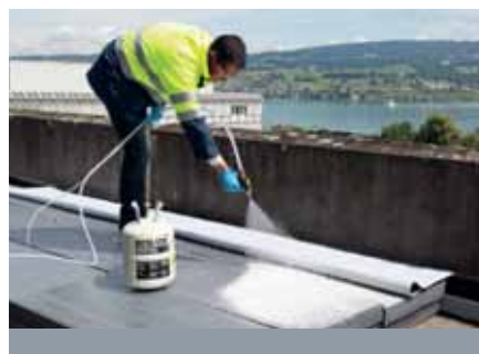
Abb. 15: Klebstoffauftrag im Abstand von 30–50cm zwischen Untergrund und Sprühpistole
