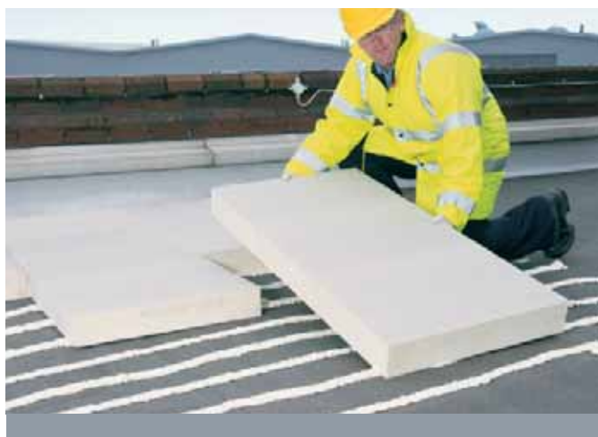
Abb. 03: Verklebung von EPS Platten mit INSTA-STIK™ ROOFING
