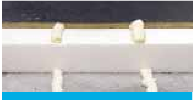
Abb. 04: Verklebung von EPS-Dämmplatten auf Beton
