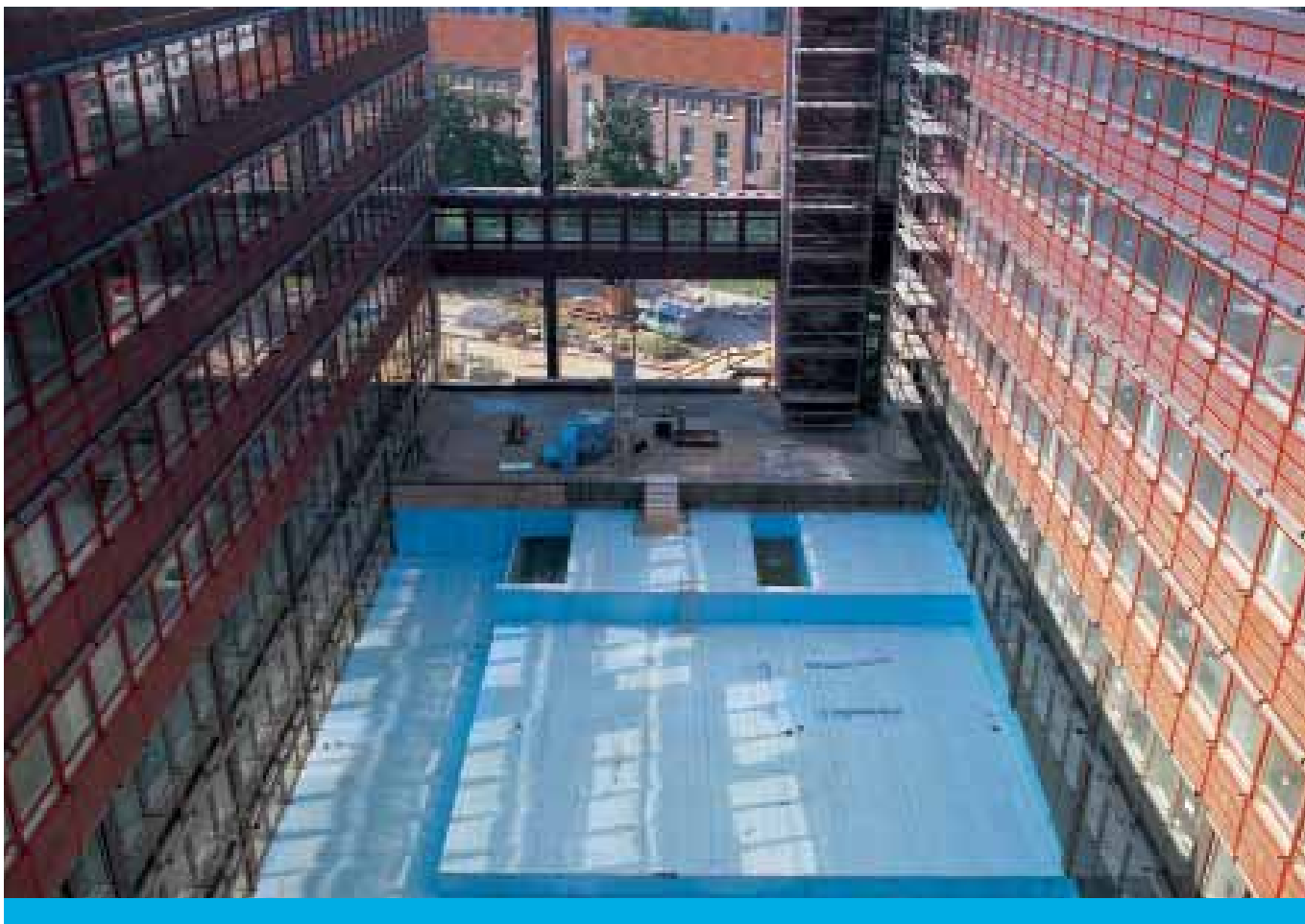
Abb. 01: Mantelbebauung der Kölnarena – ROOFMATE™ Wärmedämmung für den intensiv begrünten Innenhof und die umlaufenden Terrassen
