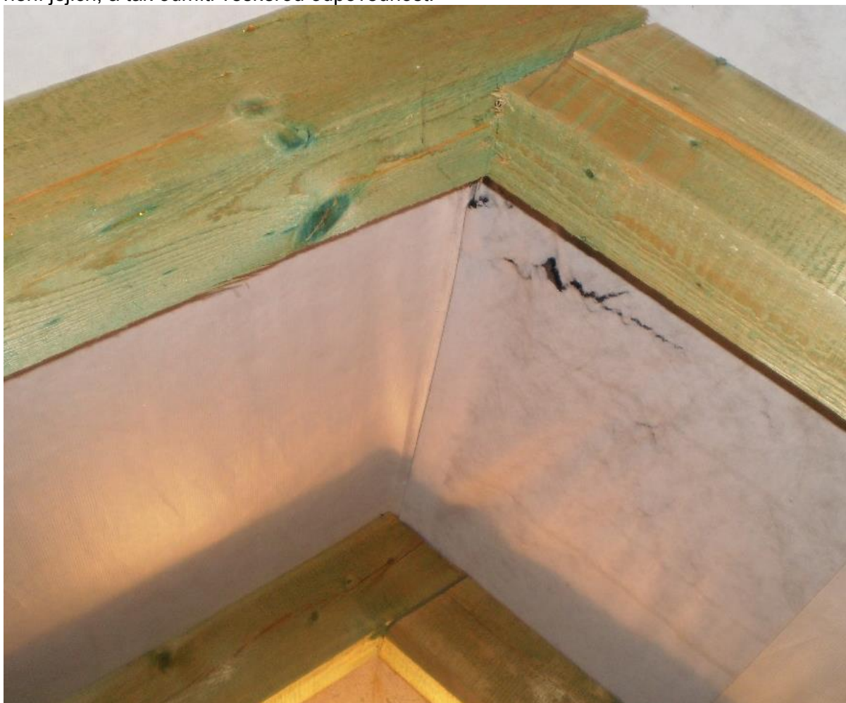
Obrázek 2: vlevo: Tyvek®, vpravo: 3vrstvá mikroporézní fólie 135 g/m 2
