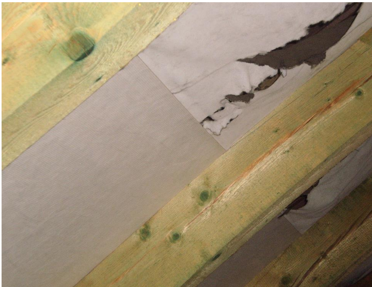
Obrázek 1: vlevo dole: Tyvek®, vpravo nahoře: 3vrstvá mikroporézní fólie 135 g/m 2
