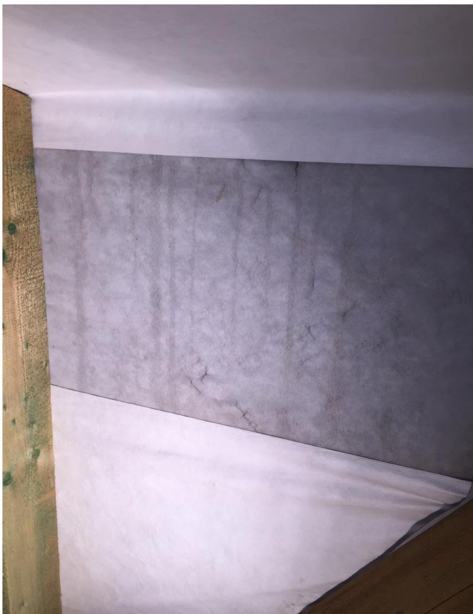
Obrázek 3: nahoře a dole: Tyvek®, uprostřed: 3vrstvá mikroporézní fólie 135 g/m 2
